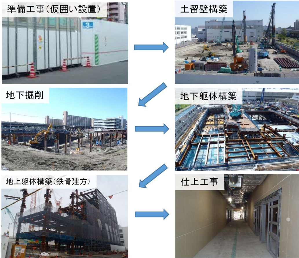
図 2-4 施工手順の概要
