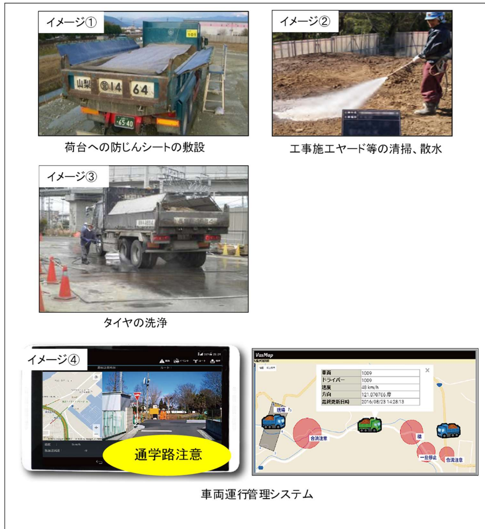
図 3-4 資材及び機械の運搬に用いる車両の運行による影響を低減するための環境保全措置
