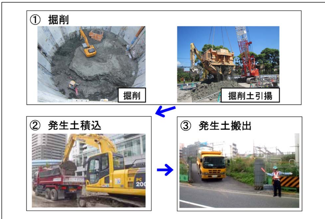
図 2-4 (6) 掘削工の施工手順 (写真は類似工事の例)
