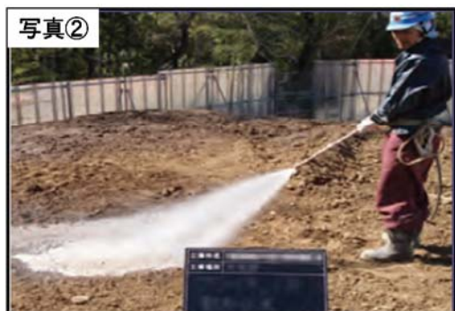
工事施工ヤード等の清掃、散水
