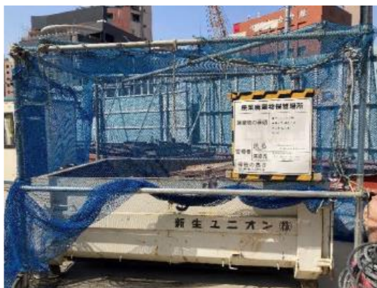
写真 7-1-4-11 副産物の分別、再資源化
