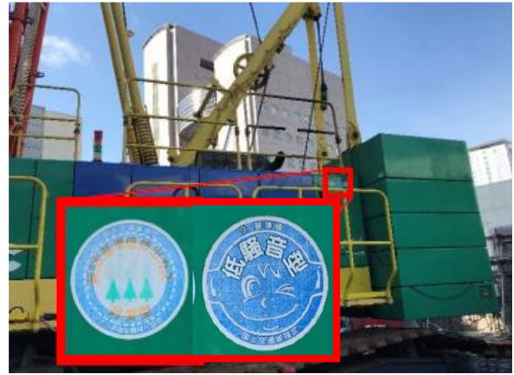
写真7-1-3-2 排出ガス対策型、低騒音型建設機械の採用
