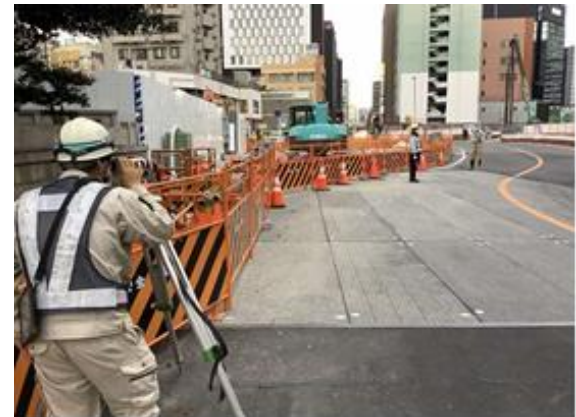
写真 7-1-4-10 山留め材及び周辺地盤の計測管理
