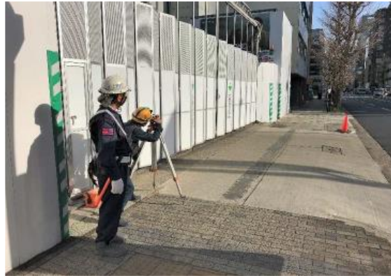
写真7-1-3-10 山留め材及び周辺地盤の計測管理
