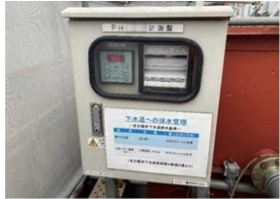
写真 7-1-4-8 工事排水の適切な処理
