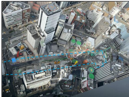
写真 3-2-3-1(5) 名古屋駅（東工区）
