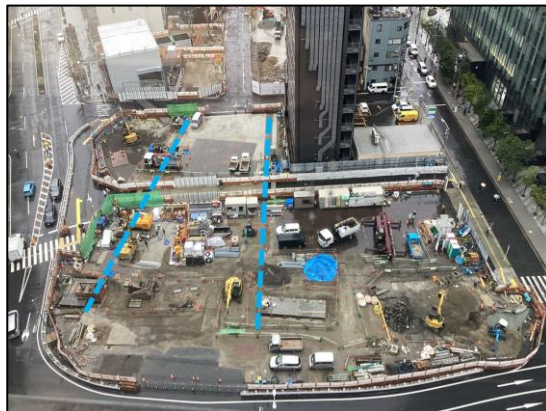
写真 3-2-3-1(7) 名古屋駅（東山線工区）
