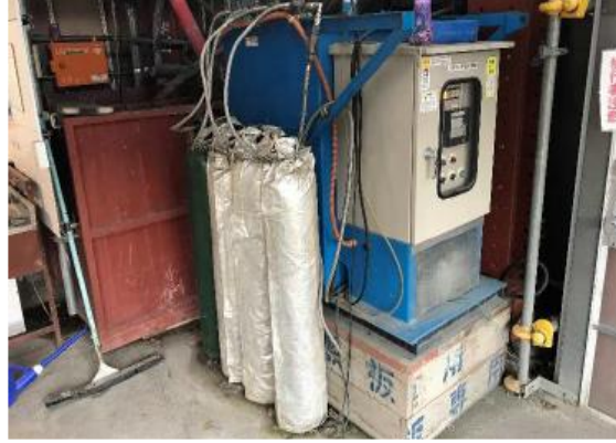
写真7-1-3-8 工事排水の適切な処理
