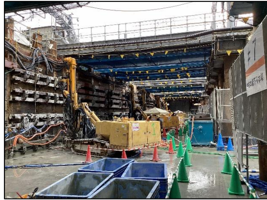
写真 3-2-3-1(10) 名古屋駅（中央東工区）
