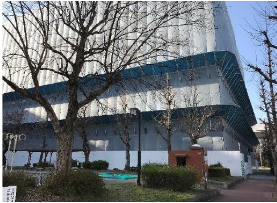
写真7-1-3-1 仮囲い等の設置状況
