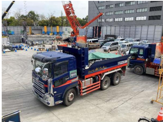
写真7-1-2-5 荷台への防塵シート敷設及び散水
