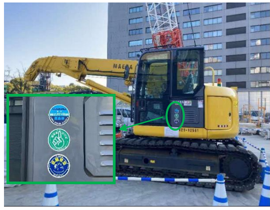
写真7-1-2-2 排出ガス対策型建設機械の採用 低騒音型建設機械の採用
