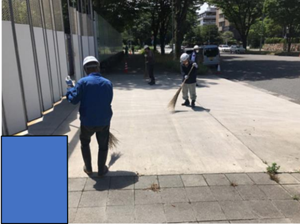
写真7-1-1-7 資材及び機械の運搬に用いる車両の出入口、周辺道路の清掃及び散水、タイヤの洗浄
