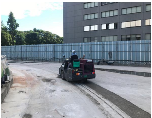
写真7-1-1-5 工事現場の清掃、散水
