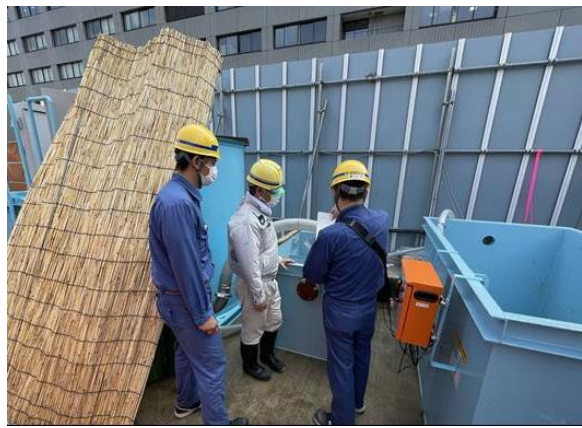
写真7-1-2-6 工事排水の適切な処理
