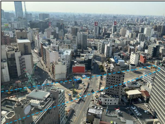
写真 3-2-3-1(13) 名古屋駅（西工区）
