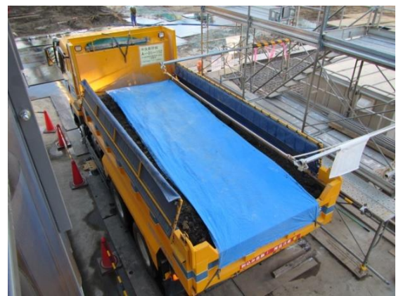
写真7-1-1-6 荷台への防じんシート敷設及び散水
