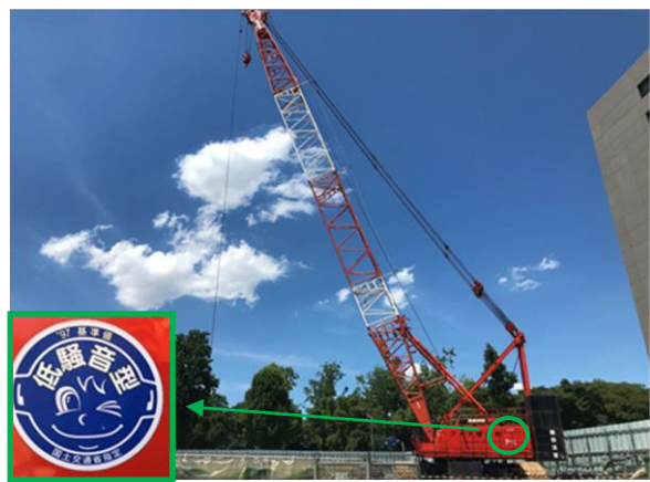
写真7-1-1-4 低騒音型建設機械の採用
