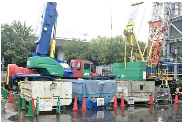
写真7-1-3-11 副産物の分別、再資源化
