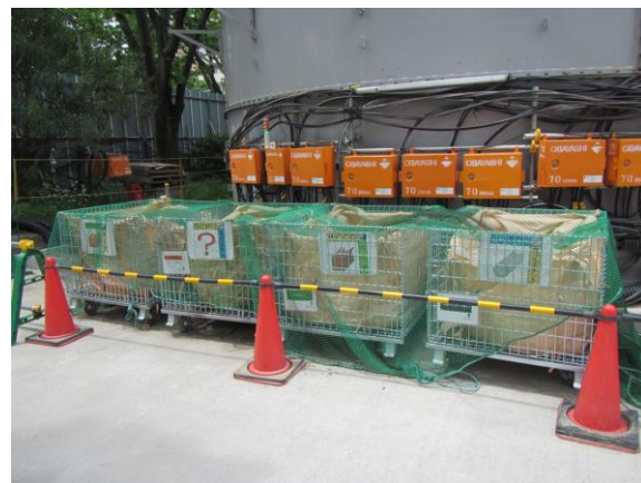
写真7-1-1-11 副産物の分別、再資源化
