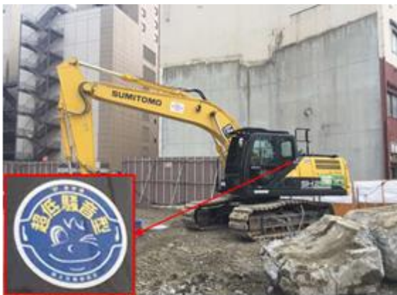
写真 7-1-4-3 低騒音型建設機械の採用
