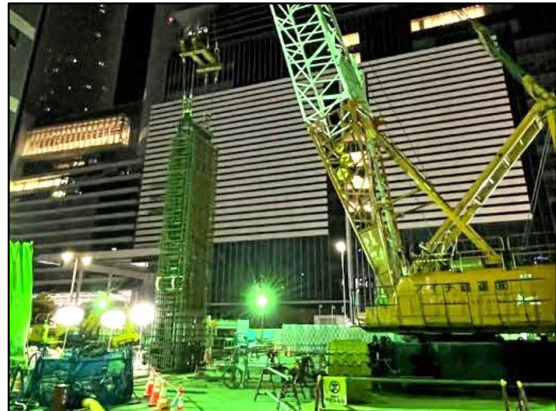
写真 3-2-3-1(8) 名古屋駅（東山線工区）
