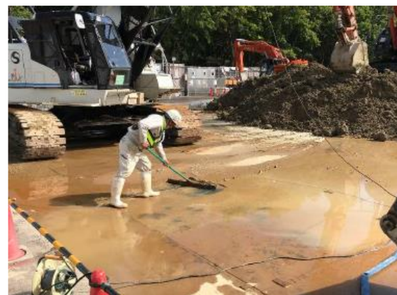
写真7-1-3-5 工事現場の清掃、散水
