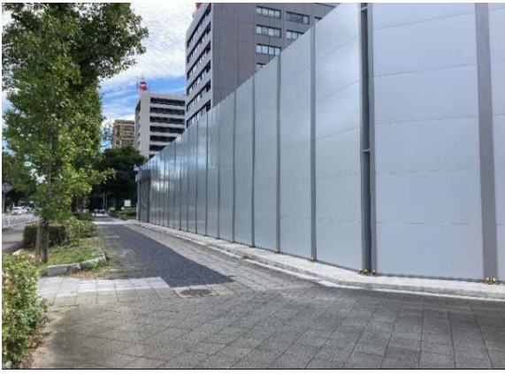
写真7-1-2-1 仮囲い等の設置状況
