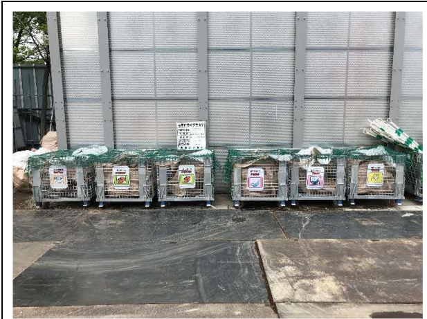
写真7-1-2-7 副産物の分別、再資源化
