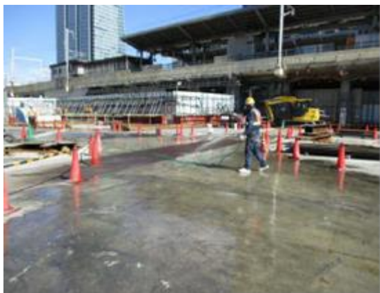
写真 7-1-4-5 工事現場の清掃、散水
