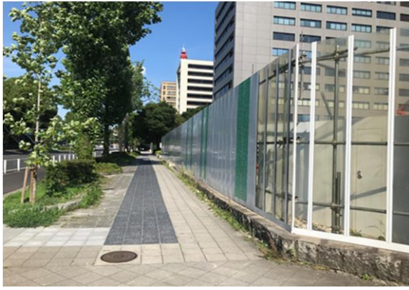
写真7-1-1-1 仮囲い等の設置状況
