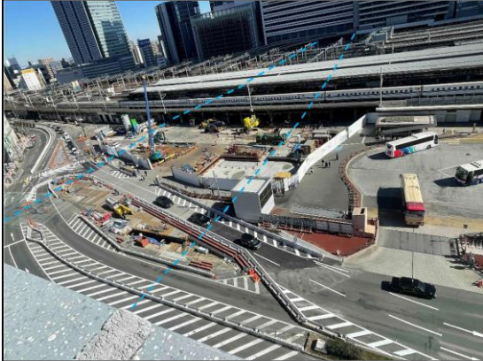
写真 3-2-3-1(11) 名古屋駅（中央西工区）
