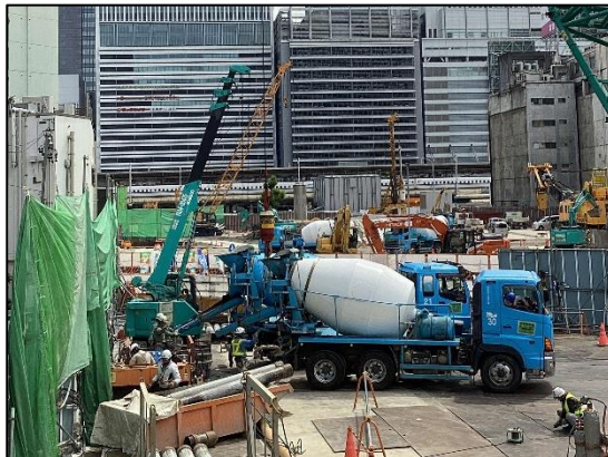
写真 3-2-3-1(14) 名古屋駅（西工区）
