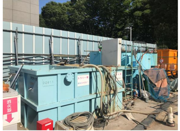
写真7-1-1-8 工事排水の適切な処理
