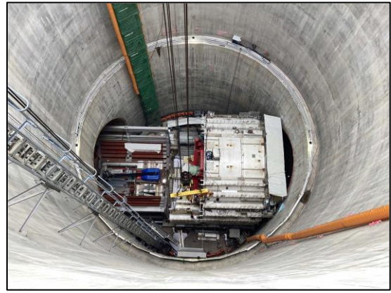
写真 3-2-3-1(2) 第一中京圏トンネル（名城工区）
