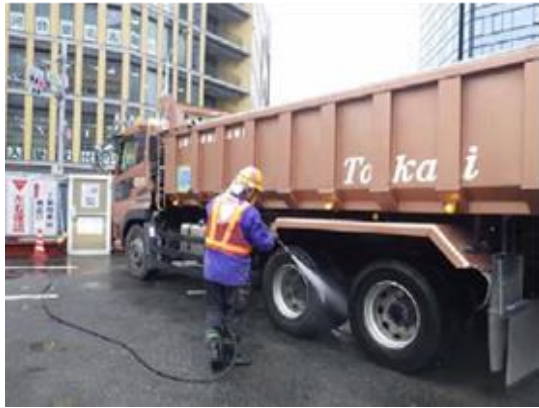
写真 7-1-4-7 資材及び機械の運搬に用いる車両の出入口、周辺道路の清掃及び散水、タイヤの洗浄
