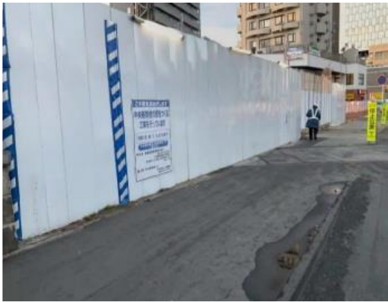
写真 7-1-4-1 仮囲い等の設置
