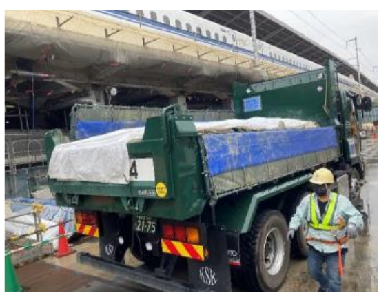
写真 7-1-4-6 荷台への防じんシート敷設及び散水
