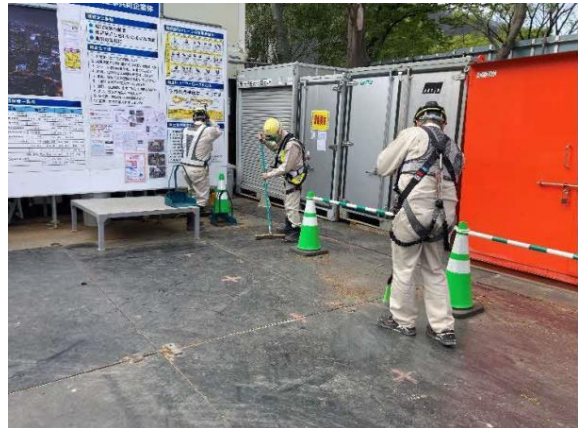
写真7-1-2-4 工事現場の清掃及び散水
