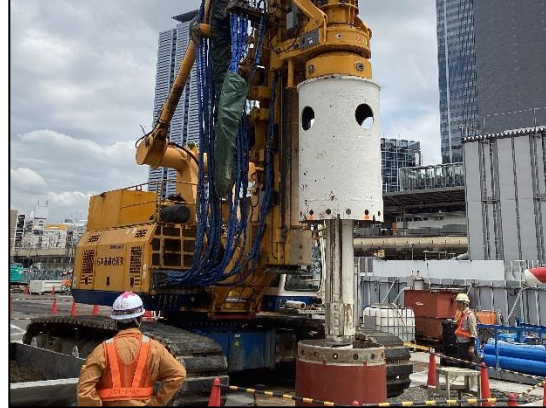
写真 3-2-3-1(12) 名古屋駅（中央西工区）
