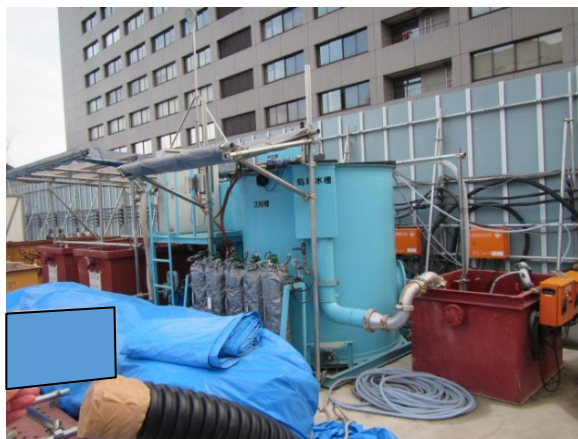
写真7-1-1-9 工事排水の適切な処理
