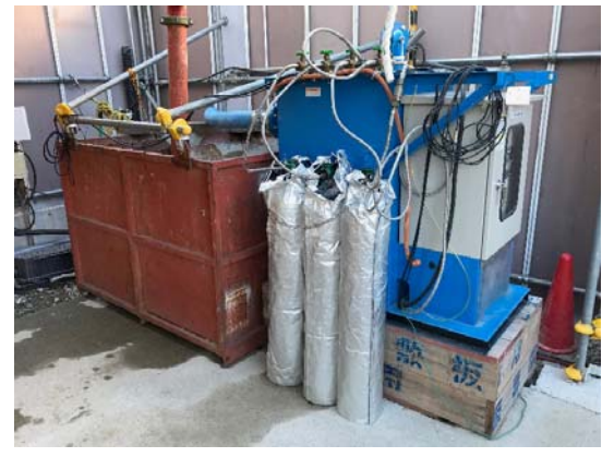
写真7-1-2-8 工事排水の適切な処理
