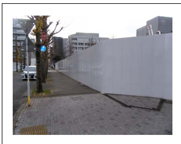
写真7-1-2-1 仮囲い等の設置
