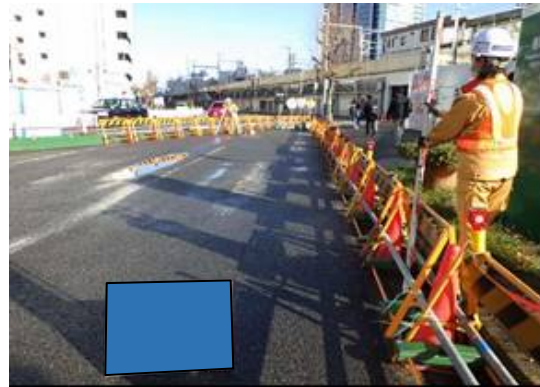
写真 7-1-3-10 山留め材及び周辺地盤の計測管理
