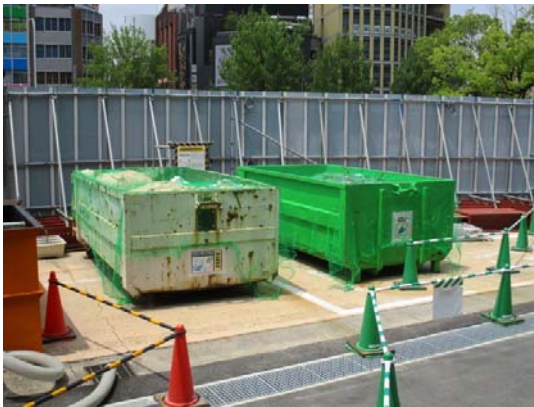
写真 7-1-3-11 副産物の分別、再資源化
