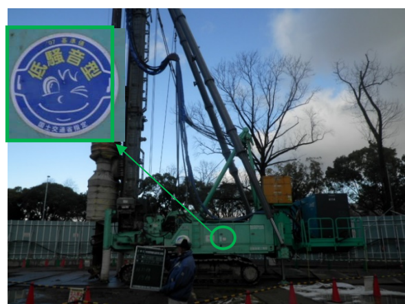
写真7-1-1-4 低騒音型建設機械の採用
