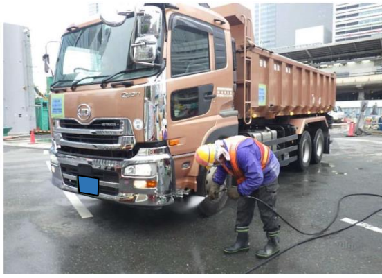
写真 7-1-3-7 資材及び機械の運搬に用いる車両の出入口、周辺道路の清掃及び散水、タイヤの洗浄
