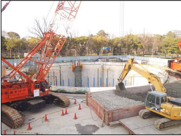
写真 3-2-3-1(1) 名城非常口（地上部）
