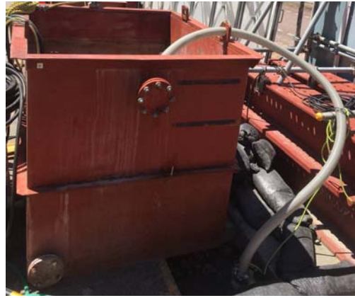
写真 7-1-3-8 工事排水の適切な処理
