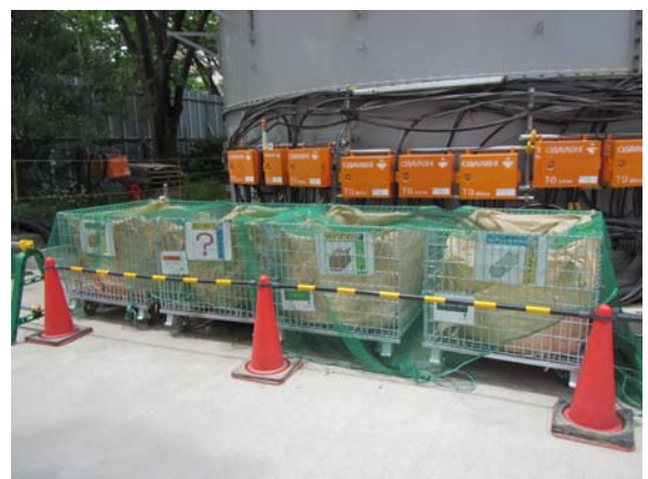
写真7-1-1-12 副産物の分別、再資源化
