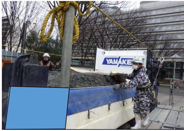
写真7-1-1-7 荷台への防じんシート敷設及び散水
