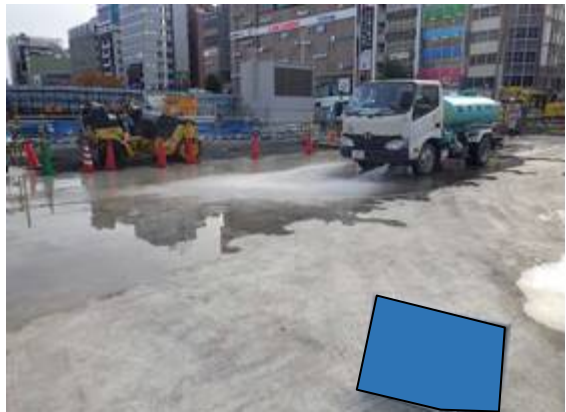
写真 7-1-3-5 工事現場の清掃、散水
