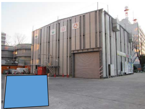
写真7-1-1-5 防音ハウスの設置
