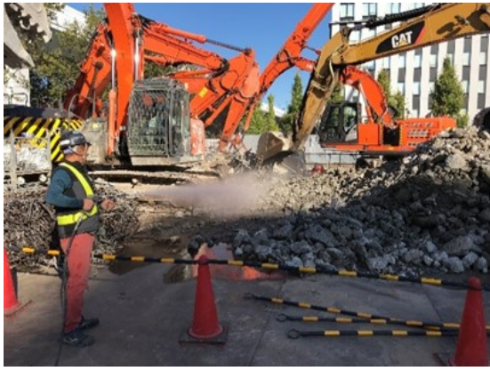
写真7-1-2-5 工事現場の清掃、散水
