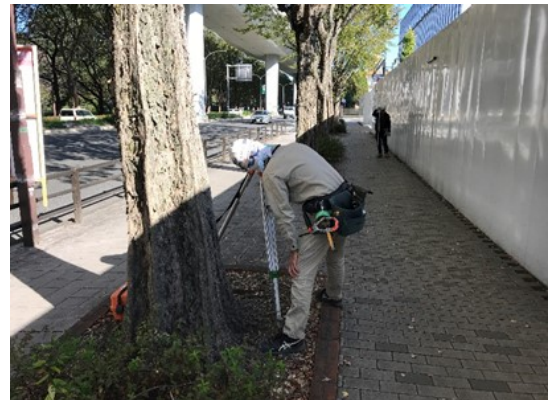
写真7-1-2-10 山留め材及び周辺地盤の計測管理
