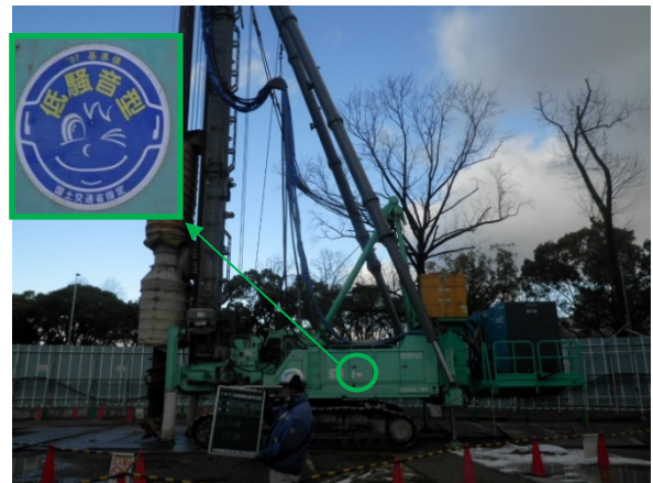
写真 6-1-1-4 低騒音型建設機械の採用
