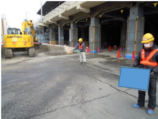
写真 6-1-2-5 工事現場の清掃、散水
