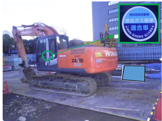
写真 6-1-1-2 排出ガス対策型建設機械の採用
