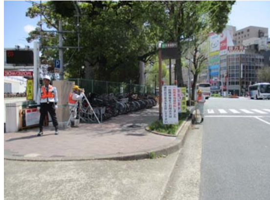
写真 6-1-2-10 山留め材及び周辺地盤の計測管理
