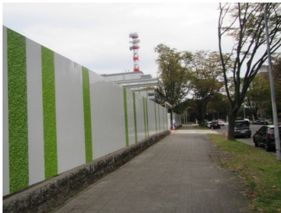
写真 6-1-1-1 仮囲い等の設置
