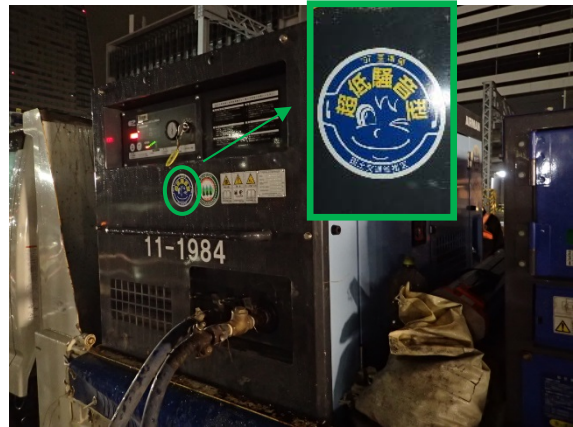
写真 6-1-2-4 低騒音型建設機械の採用
