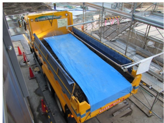
写真 6-1-1-6 荷台への防じんシート敷設及び散水
