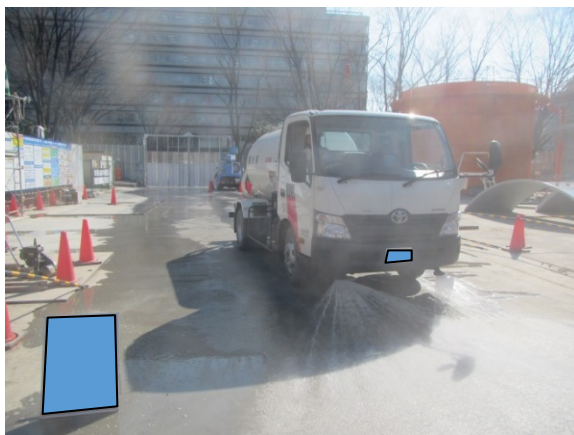
写真 6-1-1-5 工事現場の清掃、散水
