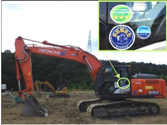
写真 6-1-1 低騒音型建設機械の採用
