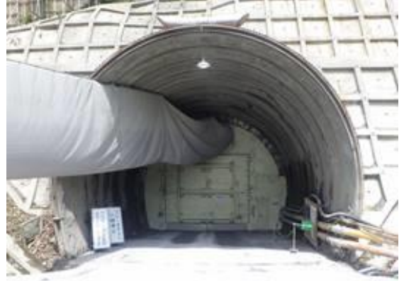
写真 6-1-2 トンネル坑口への防音扉の設置状況
