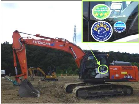
写真6-1-1 低騒音型建設機械の採用
