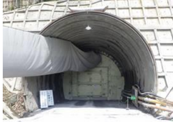
写真6-1-2 トンネル坑口への防音扉の設置
