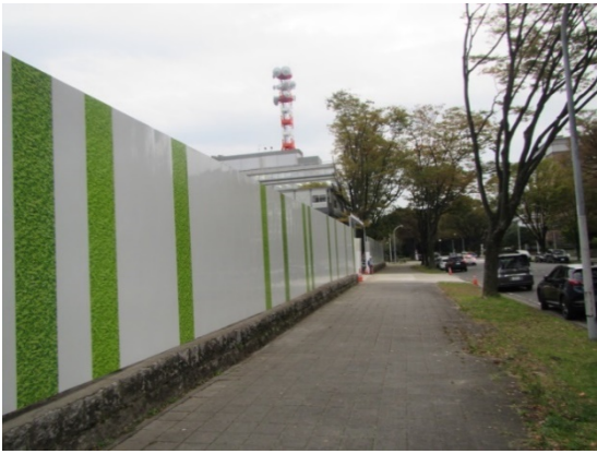
写真7-1-1-1 仮囲い等の設置
