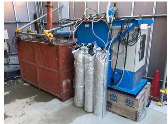
写真7-1-2-8 工事排水の適切な処理
