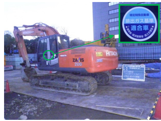
写真7-1-1-2 排出ガス対策型建設機械の採用
