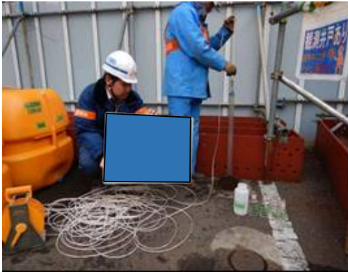
写真 7-1-3-9 地下水の継続的な監視
