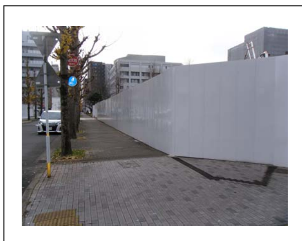
写真7-1-2-1 仮囲い等の設置
