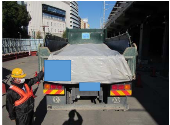
写真 7-1-3-6 荷台への防じんシート敷設及び散水
