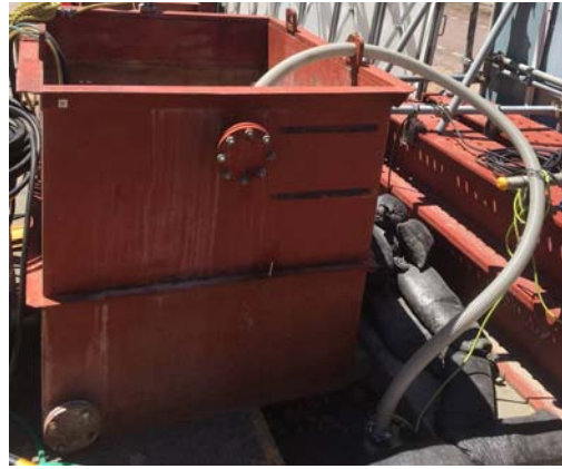
写真 7-1-3-8 工事排水の適切な処理
