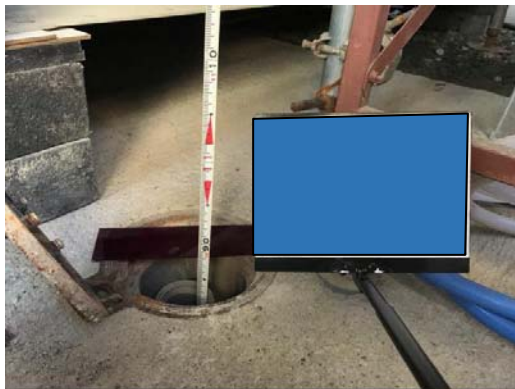
写真7-1-2-9 地下水の継続的な監視
