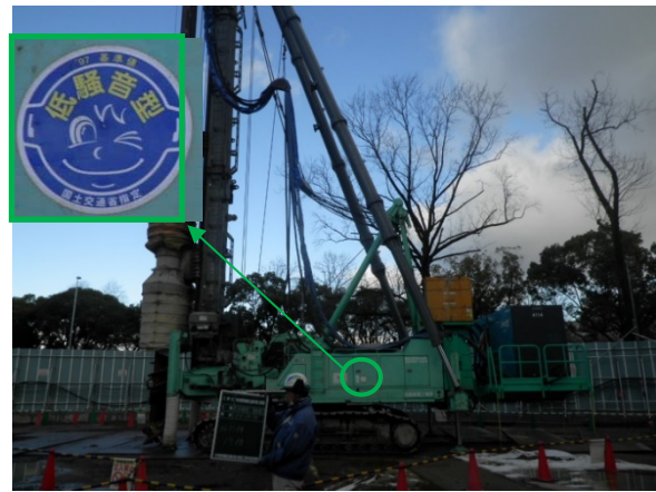
写真7-1-1-4 低騒音型建設機械の採用
