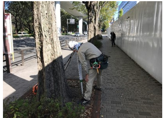
写真7-1-2-10 山留め材及び周辺地盤の計測管理
