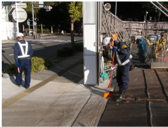
写真7-1-2-7 資材及び機械の運搬に用いる車両の出入口、周辺道路の清掃及び散水、タイヤの洗浄
