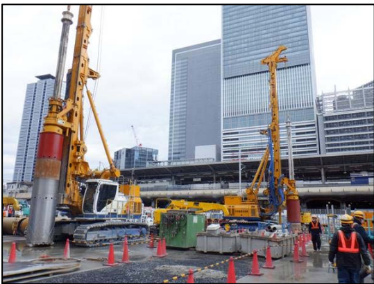
写真 3-2-3-1(6) 名古屋駅（中央西工区）
