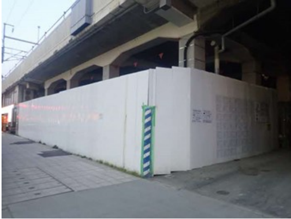
写真 7-1-3-1 仮囲い等の設置
