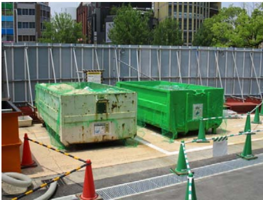
写真 7-1-3-11 副産物の分別、再資源化
