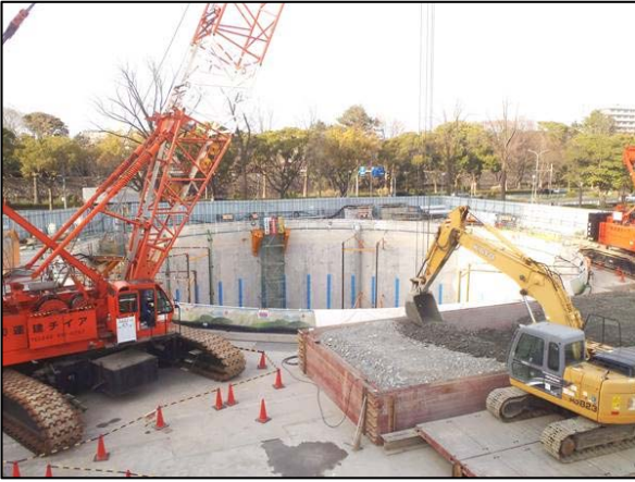
写真 3-2-3-1(1) 名城非常口（地上部）
