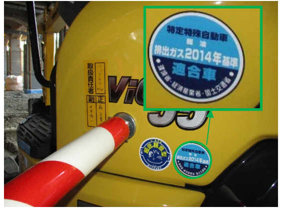
写真 7-1-3-2 排出ガス対策型建設機械の採用
