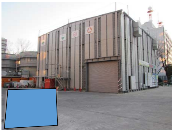
写真7-1-1-5 防音ハウスの設置
