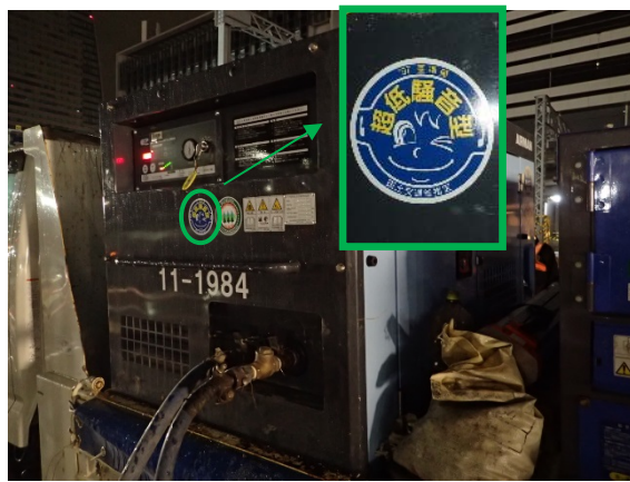
写真 7-1-3-3 低騒音型建設機械の採用
