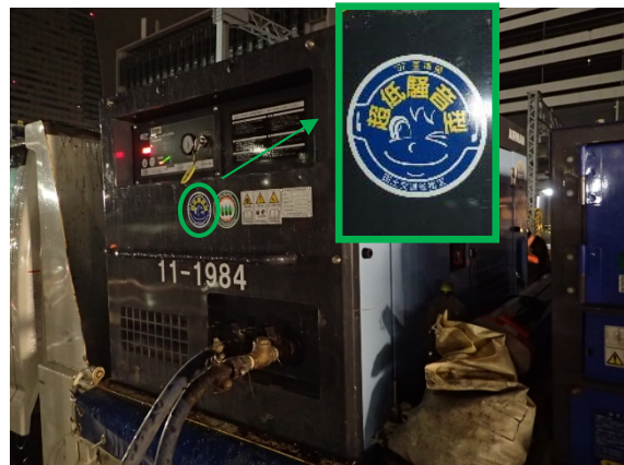
写真 6-1-2-4 低騒音型建設機械の採用
