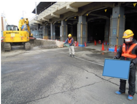
写真 6-1-2-5 工事現場の清掃、散水
