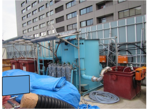
写真 6-1-1-8 工事排水の適切な処理
