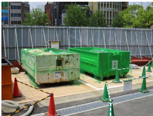
写真 6-1-2-11 副産物の分別、再資源化
