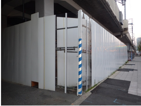
写真 6-1-2-1 仮囲い等の設置
