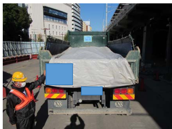
写真 6-1-2-6 荷台への防じんシート敷設及び散水
