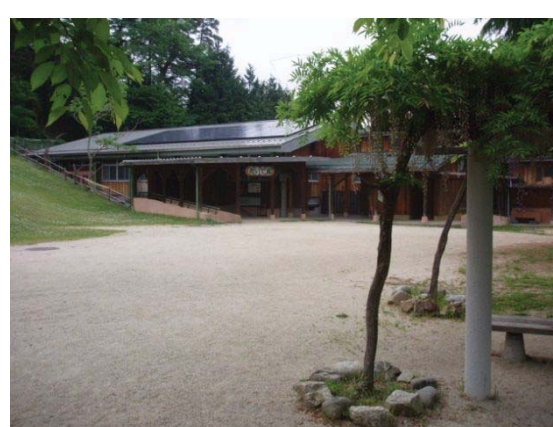
野外施設(おいで館)の状況
