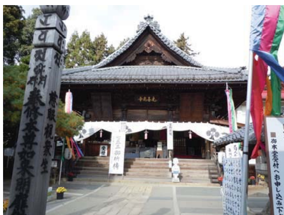
本堂周辺の状況(2)
