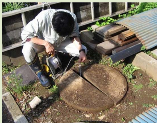
地下水の調査状況
