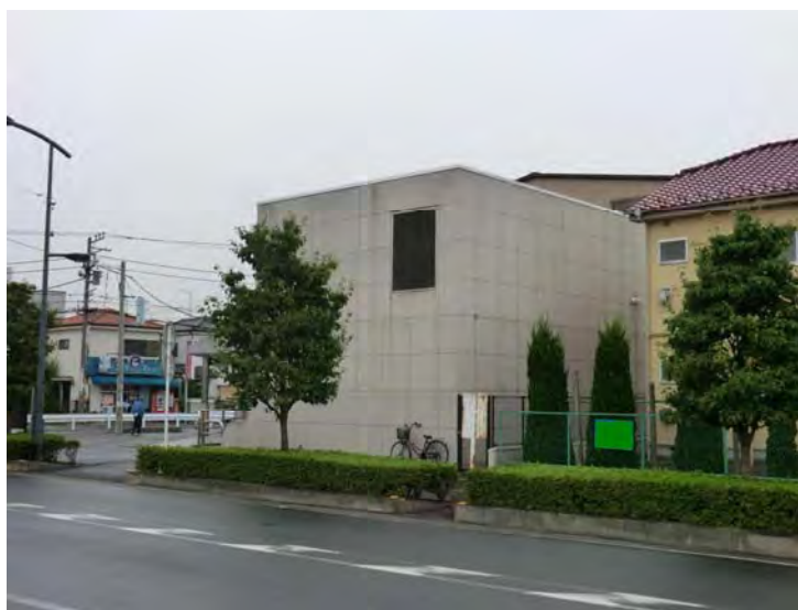
写真：埼玉高速鉄道（株）「戸塚安行駅」の換気施設
