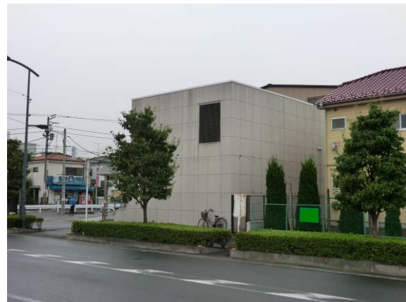
写真：埼玉高速鉄道（株）「戸塚安行駅」の換気施設
