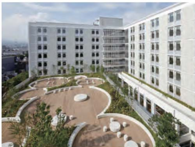
図 19-3-2-5 総合研修センター（屋上緑化）
