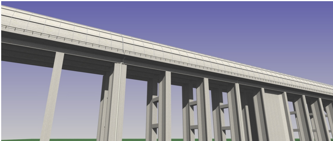
図 17-1-2-8 新形式高架橋（防音防災フード部）
