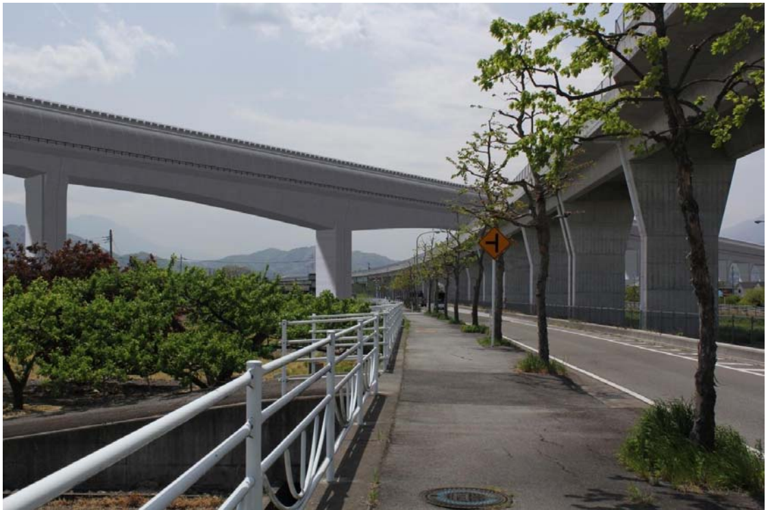
图 17-1-2-17 中部横断自動車道架道橋
