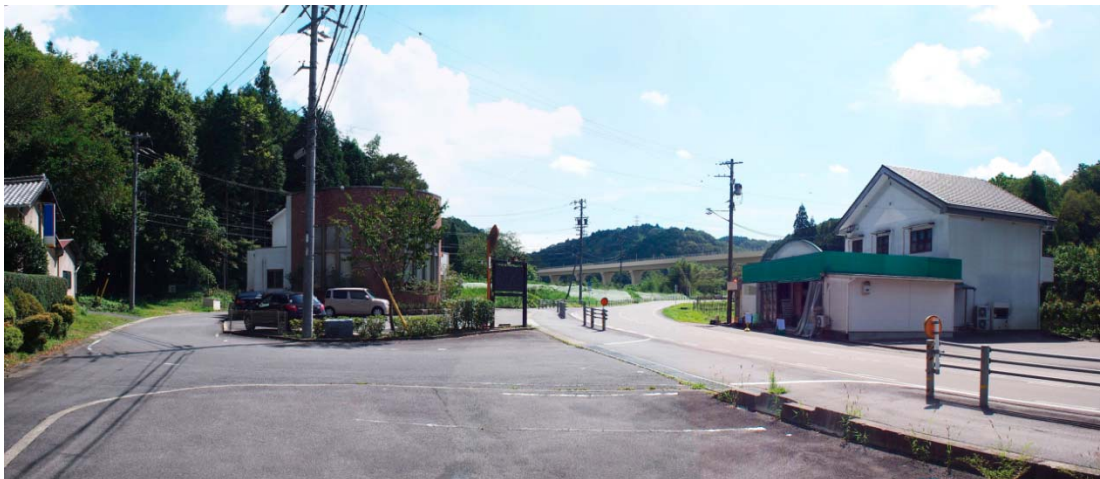
图 17-1-2-22 久々利高架橋
