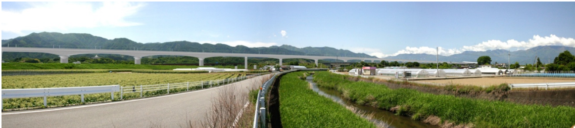
图 17-1-2-14 笛吹川・濁川桥梁及び第2中央自動車道架道橋
