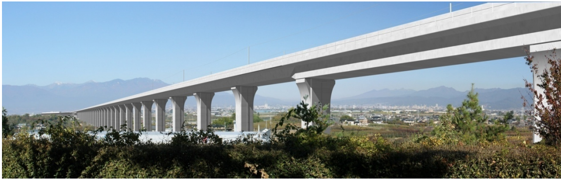
图 17-1-2-13 第1中央自動車道架道橋
