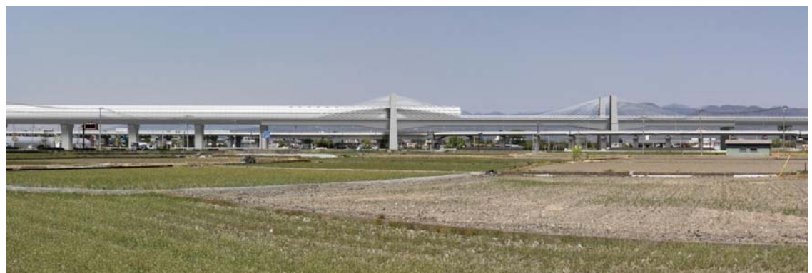
图 17-1-2-15 新山梨環状道路架道橋
