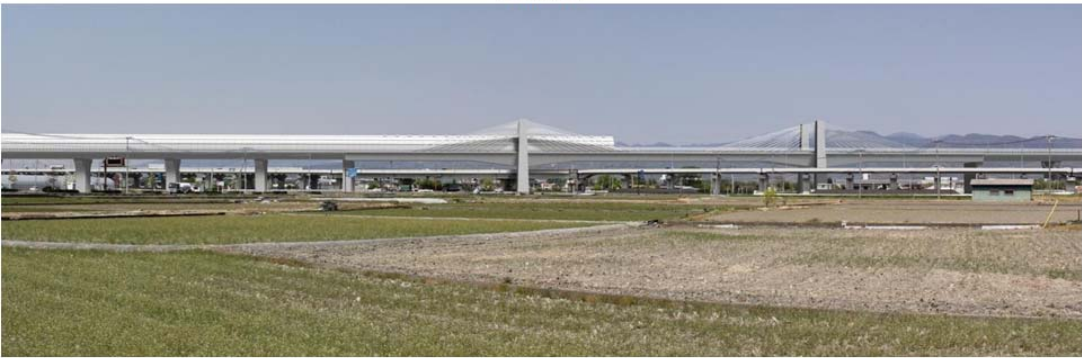
エクストラドーズド橋
