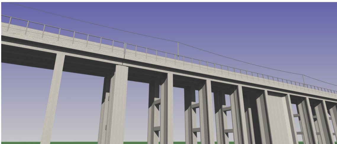
図 17-1-2-9 新形式高架橋（防音壁部）
