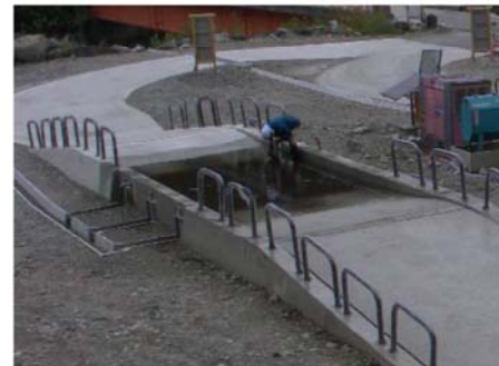
写真-4 普通車用 洗浄プール
