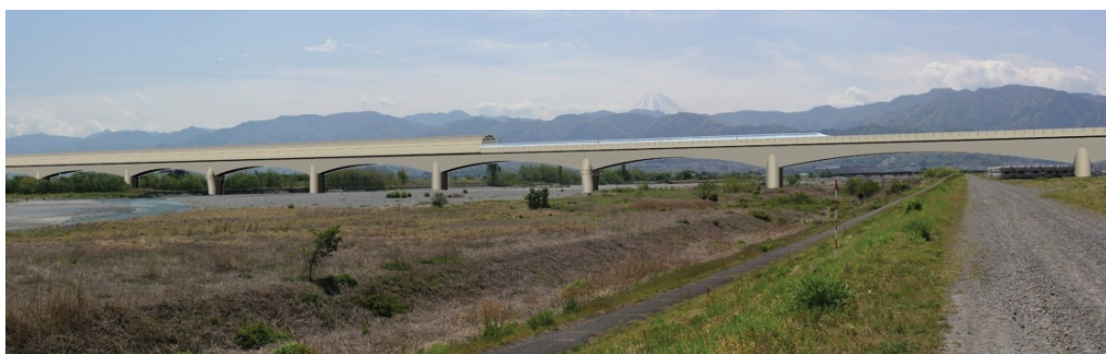
＜釜無川右岸（南アルプス市）からの景観イメージ＞
