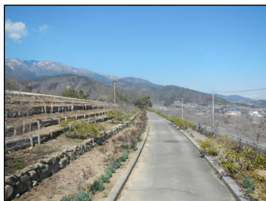
遊歩道の状況
