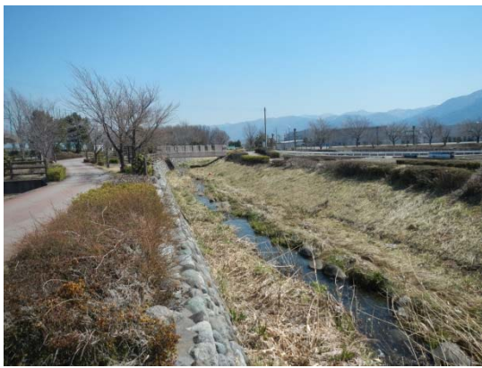
河川整備の状況
