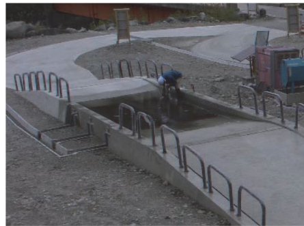
写真4 普通車用 洗浄プール
