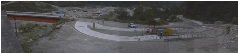
写真2 タイヤ洗浄装置（全景）
