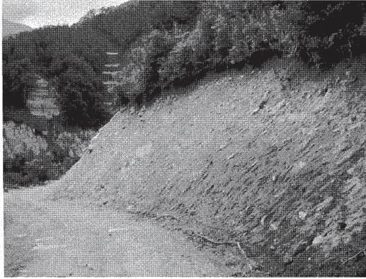
写真-1 通ヶ沢治山運搬路
