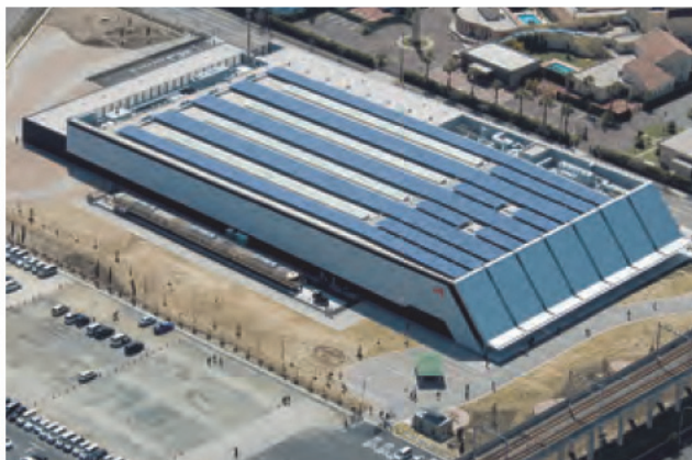
図 13-3-2-6 リニア・鉄道館（太陽光発電システム）
