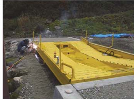
写真3 大型車両用 洗浄ピット装置
