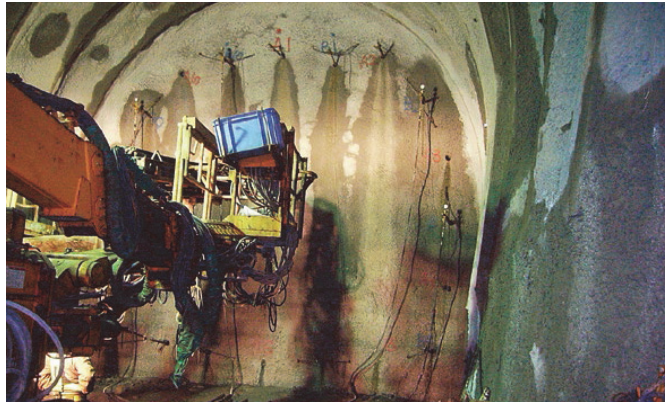
図 5-3-3 薬液注入工の施工例
