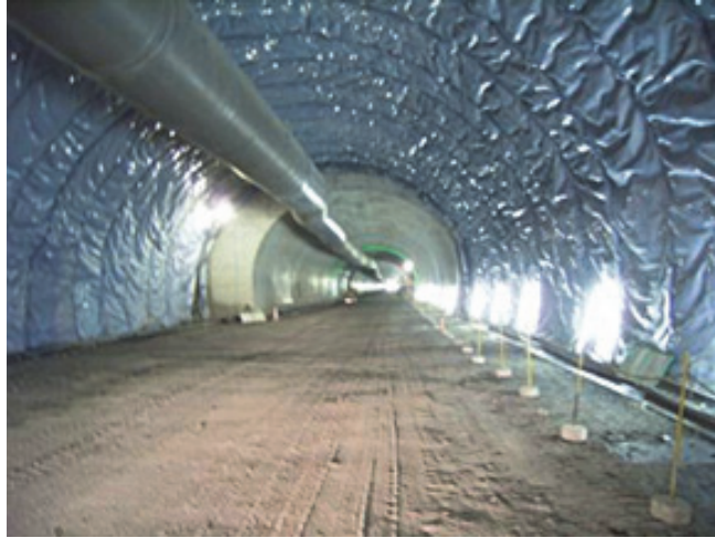
図 5-3-5 防水シートの施工例（一般国道 191 号線 萩・三隅道路） （国土交通省 中国地方整備局 山口河川国道事務所ホームページより抜粋）
