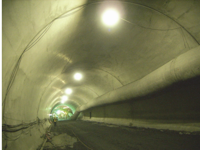
図 5-3-6 覆エコンクリートの施工例（一般県道 常神三方線 神子トンネル） （福井県 敦賀土木事務所 道路改良主要事業 ホームページより抜粋）
