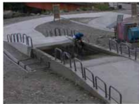
写真4 普通車用 洗浄プール
