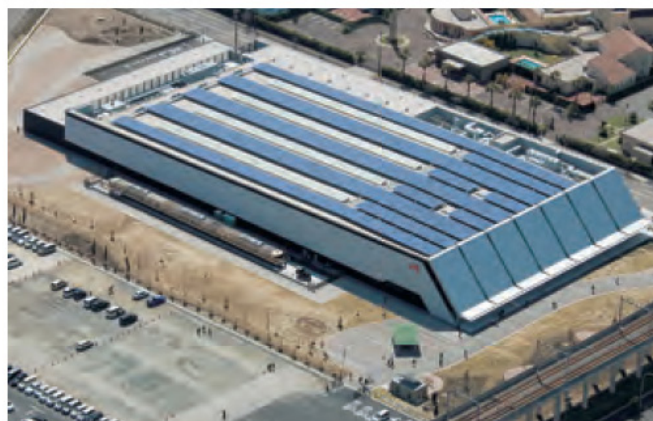
図 24-3-2-6 リニア・鉄道館（太陽光発電システム）
