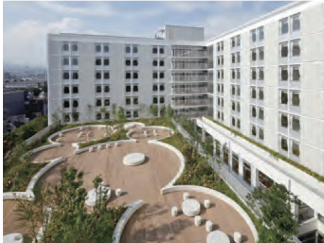
図 24-3-2-5 総合研修センター（屋上緑化）
