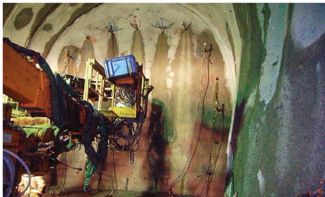
図 7-5-3 薬液注入工の施工例
