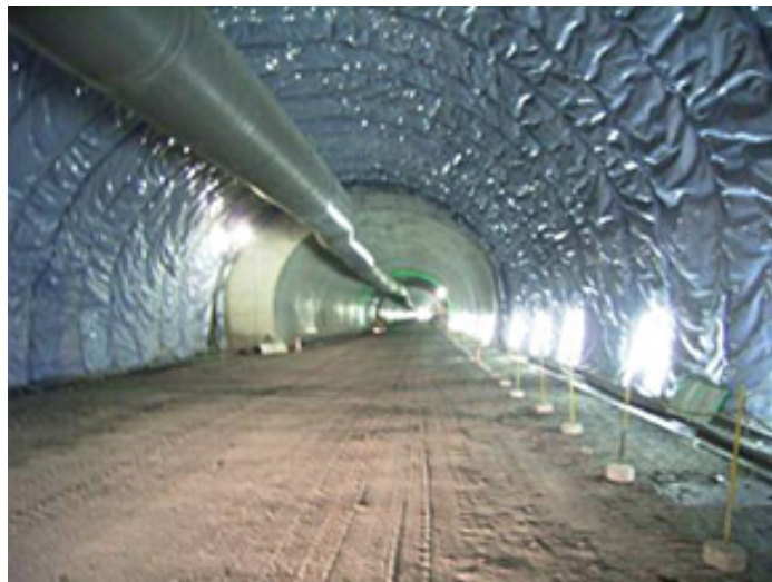
図 7-5-5 防水シートの施工例（一般国道 191 号線 萩・三隅道路） （国土交通省 中国地方整備局 山口河川国道事務所ホームページより抜粋）
