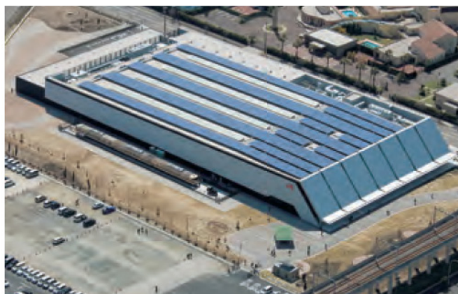
図 19-3-2-6 リニア・鉄道館（太陽光発電システム）
