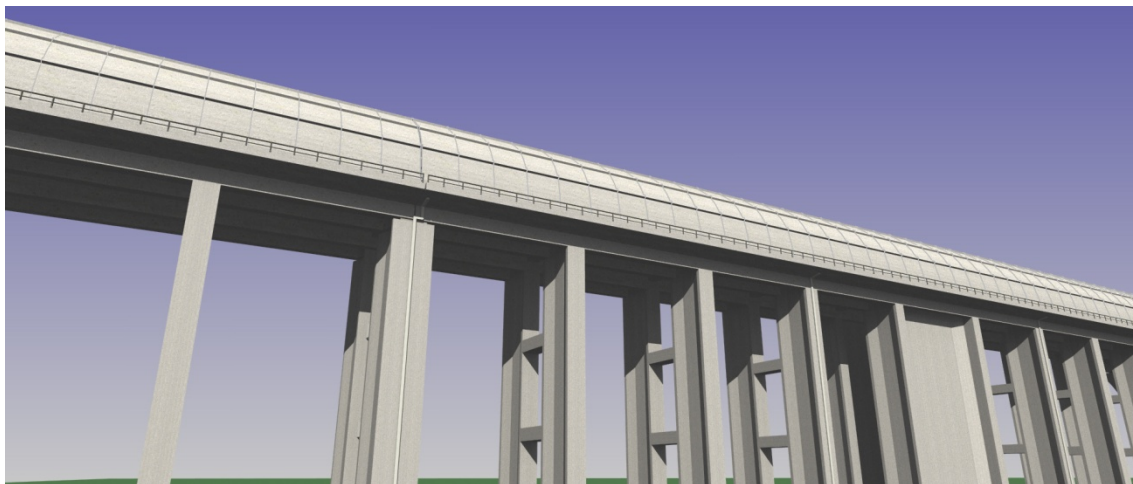
図 17-1-2-8 新形式高架橋（防音防災フード部）
