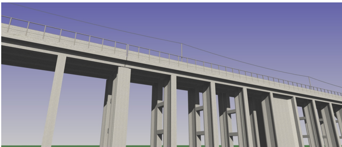
図 17-1-2-9 新形式高架橋（防音壁部）
