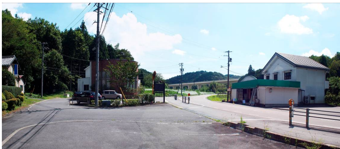
図 17-1-2-24 久々利高架橋
