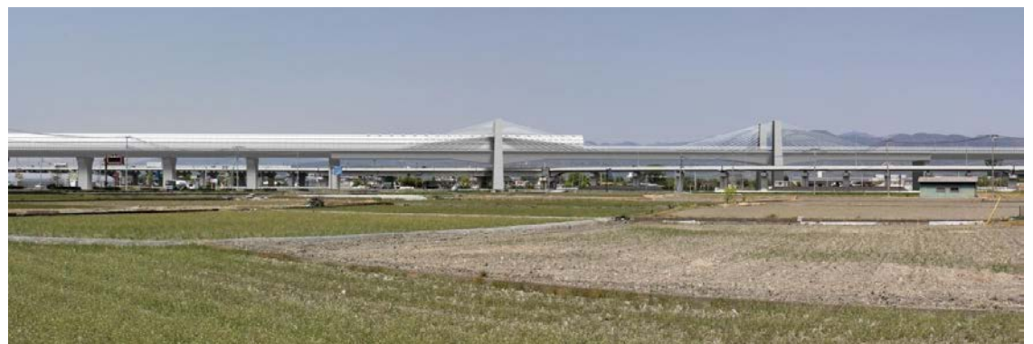
図 17-1-2-15 新山梨環状道路架道橋
