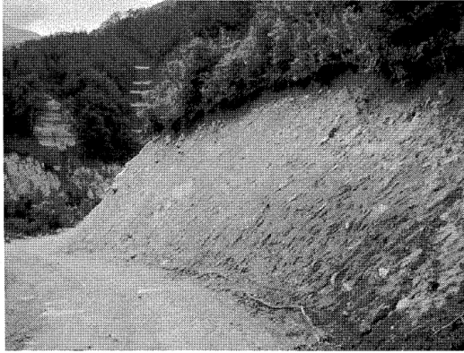
写真-1 通ヶ沢治山運搬路
