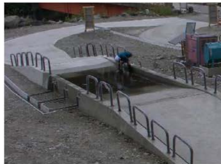
写真4 普通車用 洗浄プール
