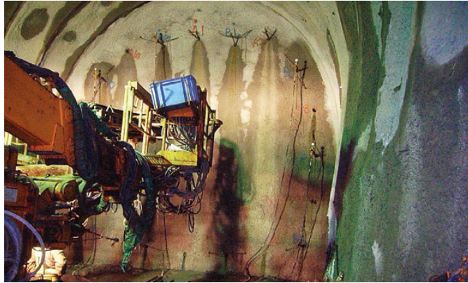
図 7-4-3 薬液注入工の施工例
