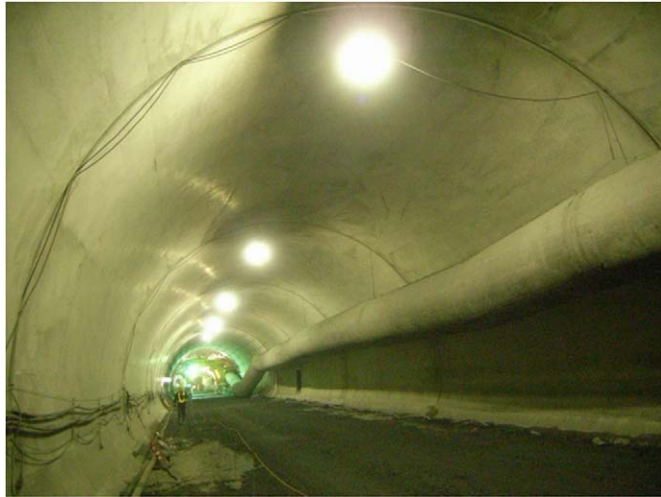
図 6-6-6 覆工コンクリートの施工例（一般県道 常神三方線 神子トンネル） （福井県 敦賀土木事務所 道路改良主要事業 ホームページより抜粋）
