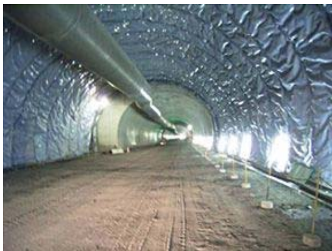
図 6-6-5 防水シートの施工例（一般国道 191 号線 萩・三隅道路） （国土交通省 中国地方整備局 山口河川国道事務所ホームページより抜粋）
